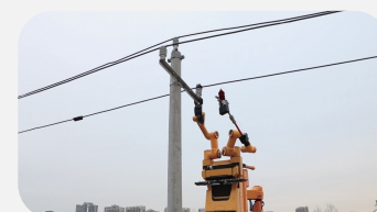
安装过电压保护器
